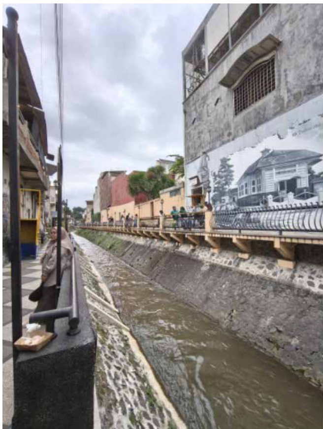
Sungai Metro yang mengalir deras
