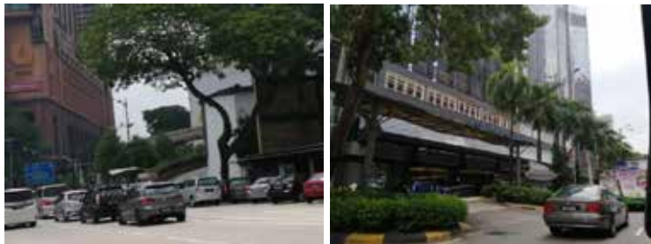
(a) Jalan Imbi
